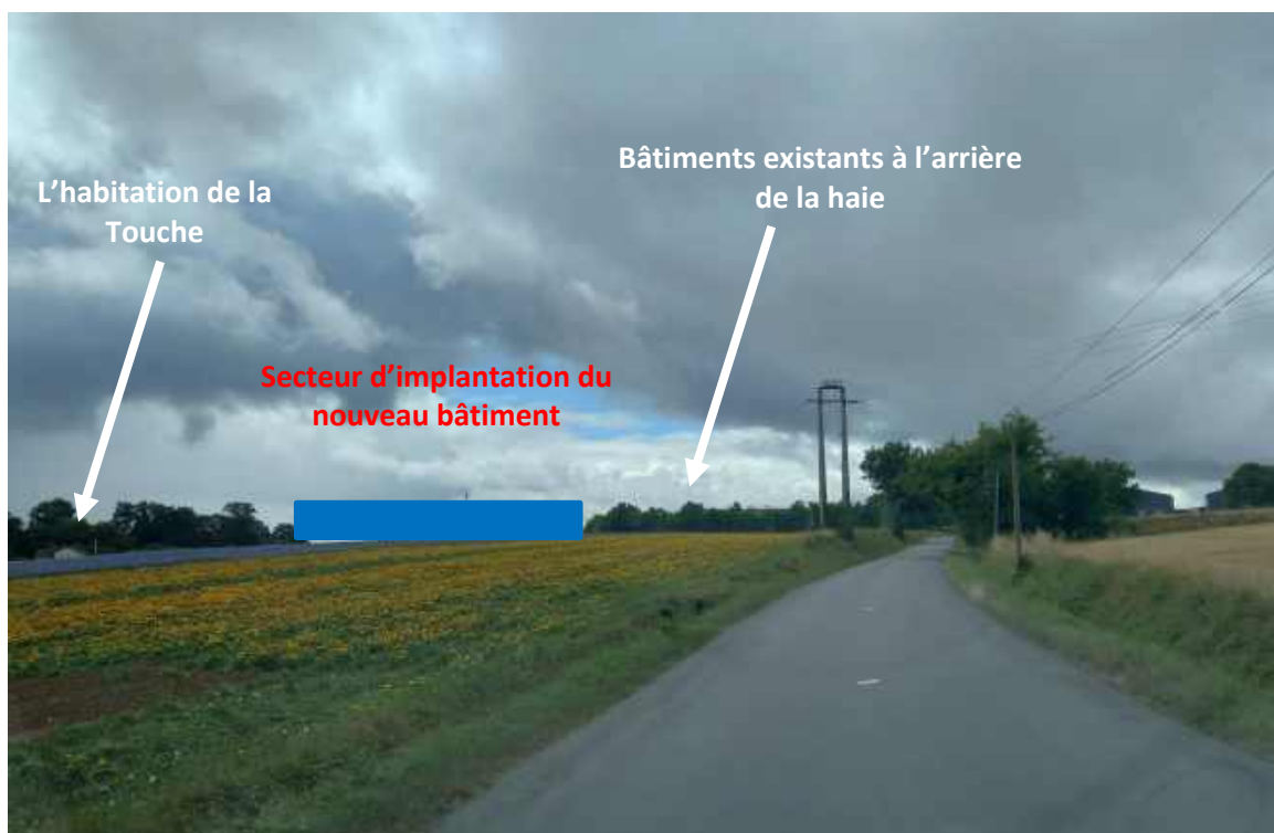
Figure 4 : Prise de vue n°2 depuis la vallée de la Touche
